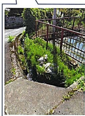
蓋のない水路
