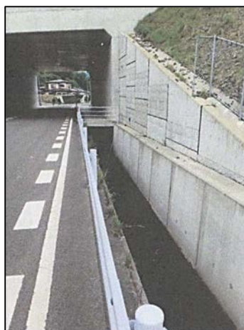
蓋のない深い水路
