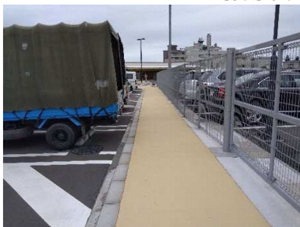
カラー舗装（大崎市 道の駅大崎）
