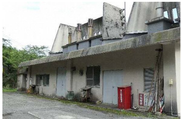
写真 16. 排気筒（斎場北側）
