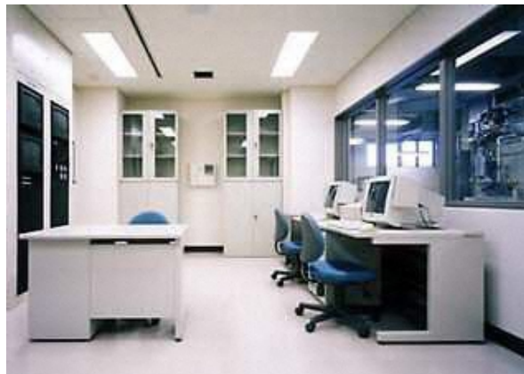
制御室（牛久市 うしくあみ斎場）
