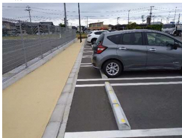
カラー舗装（大崎市 道の駅大崎）
