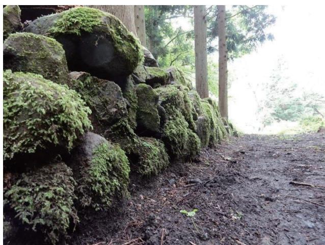
図 240 沿道の石積み（金山宿南側）
