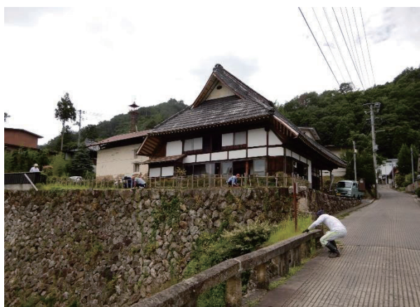
図 233 山田屋石垣及び視橋の除草
