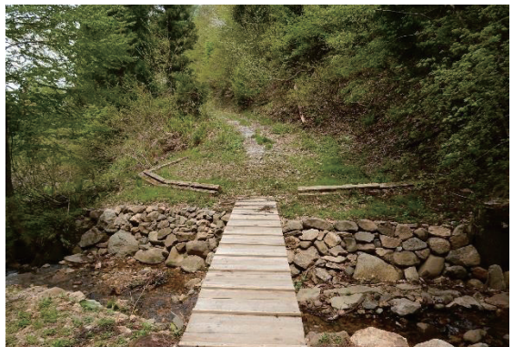
図 200 林道と史跡を結ぶ木橋（幅員 70cm）
