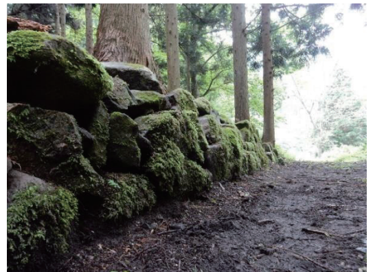
図190 街道と沿道の石積み
