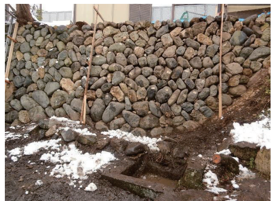
図 158 竣工。H30（2018）年 12 月 6 日
