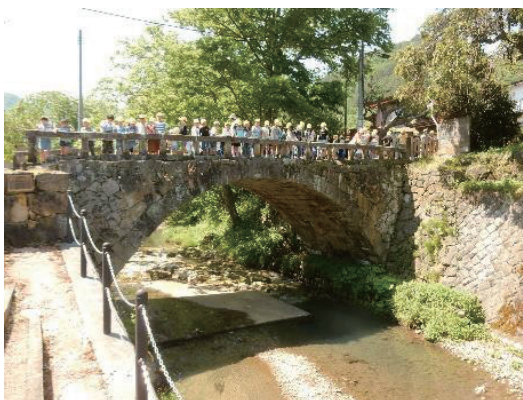
図 138 金山川に架かる石橋「新橋」
