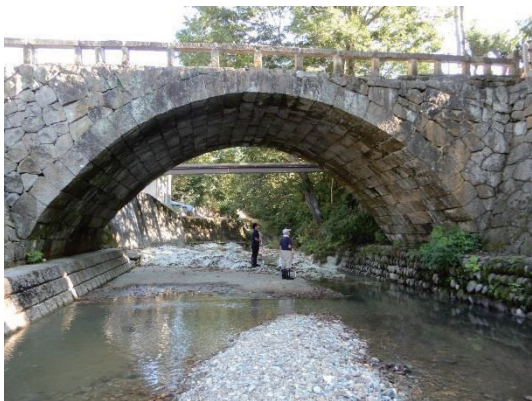
図 146 水衝部の河床洗掘対策済の新橋
