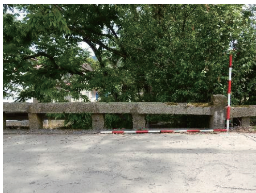
図 139 安全対策が必要な石橋の高欄
