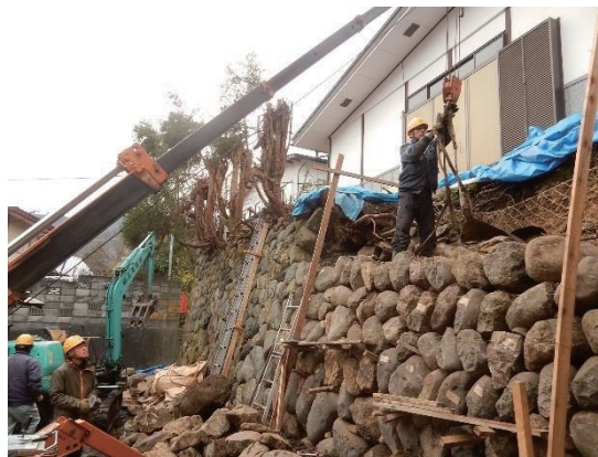
図 157 上段積み戻しはクレーンを使用
