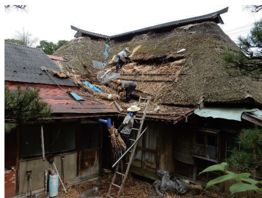
図 132 檜下宿での茅葺屋根修復
