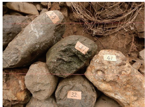
図 156 写真照合した石は付番で積戻し
