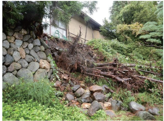
図 148 接近した台風の影響で倒伏したスギと崩落した石垣
