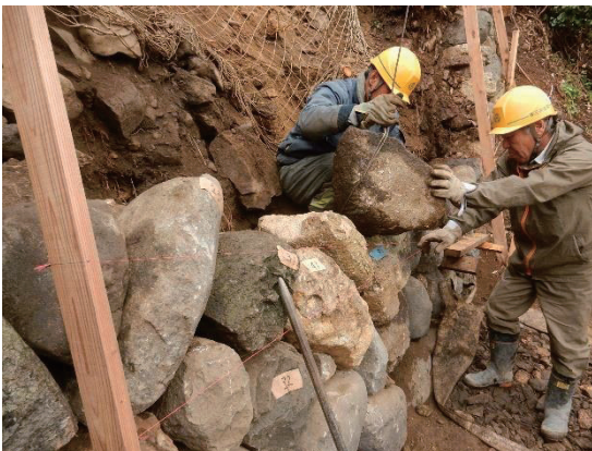
図 155 崩落した石の積戻し
