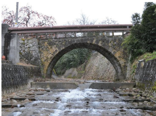
図 140 視橋（下流から撮影）
