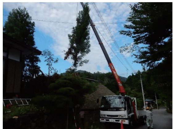
図 149 二次被害を防ぐため石垣天端のスギを伐採・撤去
