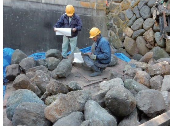
図 152 崩落前の石垣写真と転石を照合
