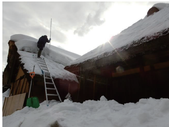
図 28 檜下の茅葺古民家で雪下ろし(2018)
