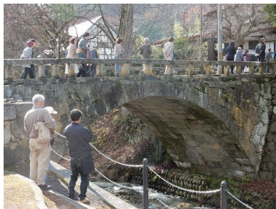
図 13 明治期に作られた新橋
