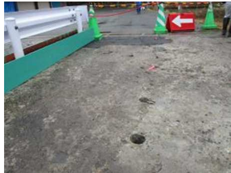
舗装版撤去後・コア削孔後 床版状況
