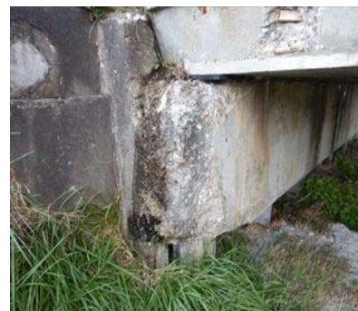
谷地橋（下部工）
