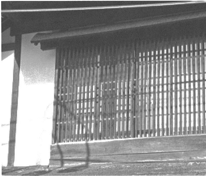
道路側の2階の木製格子
