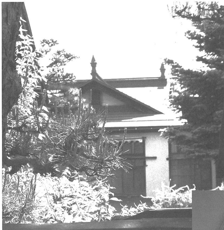
中庭から医院の屋根を見る
