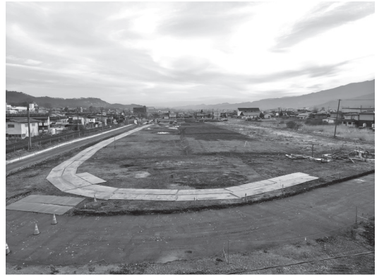
造成中の公園住宅イッテ
