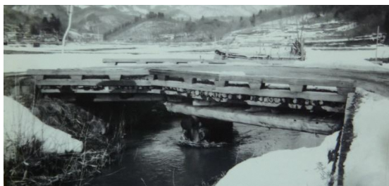
水木造の坊沢二の橋
