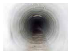
工事後の下水道管
