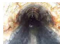
工事前の下水道管
