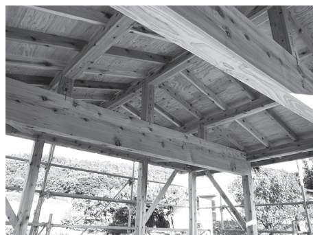
建物の構造材に市産材が活用された事例
