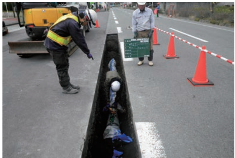
水道管更新工事の様子
