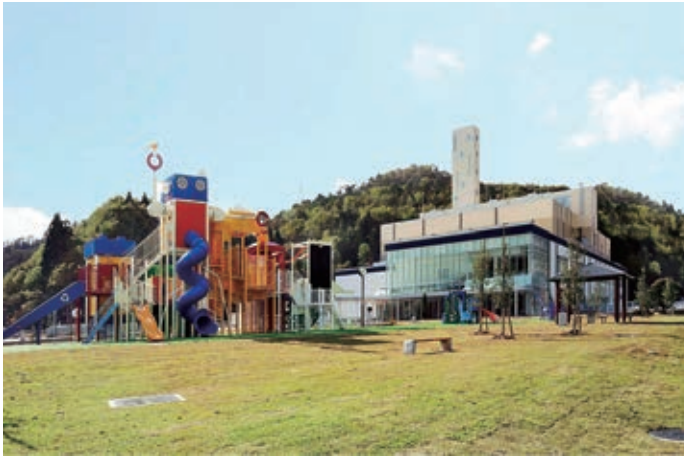
市内にあるエネルギー回収施設(川口)
