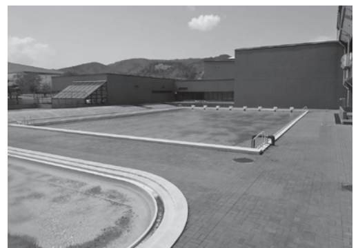
市民プールの代替施設となる南小学校プール
