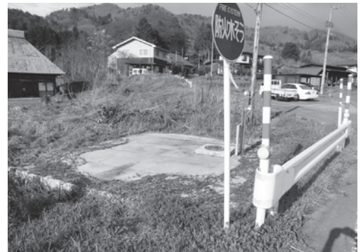
有蓋化された防火水槽
