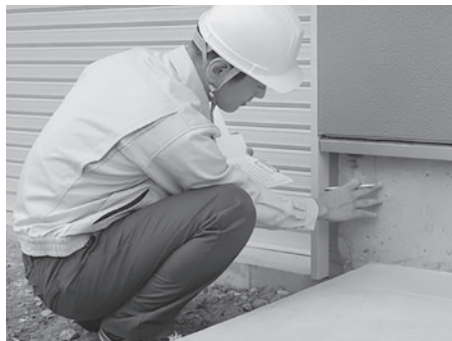
耐震診断作業の様子
