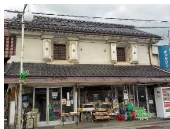
平入りの勾配屋根と漆喰壁
