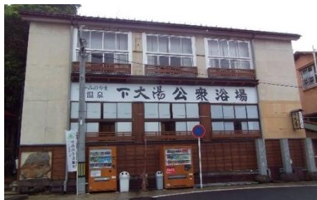
下大湯 軒高約8.0m 高さ約9.1m
