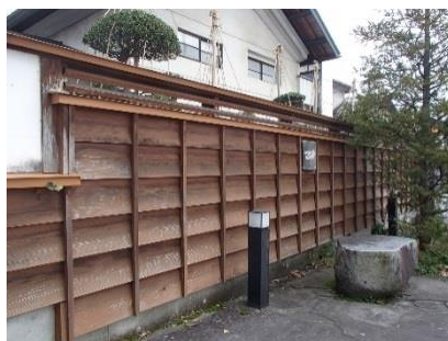
景観に配慮した木塀
