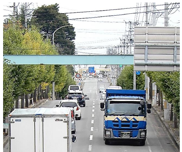
西山陸橋のすぐ北で国道上を横切る「湯尻川」
