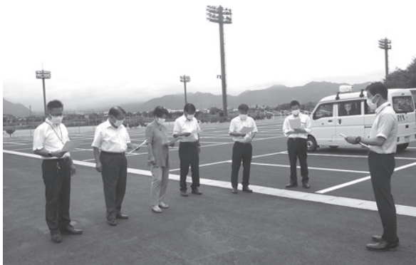
体育文化センター駐車場等舗装工事を調査
