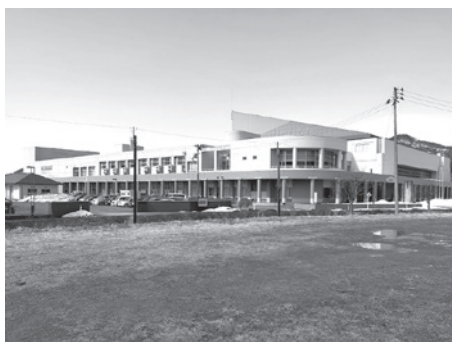
ZEB化工事が行われる体育文化センター
