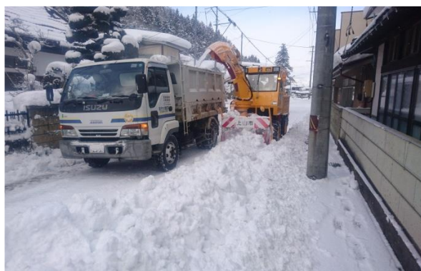
生活道路の排雪作業
