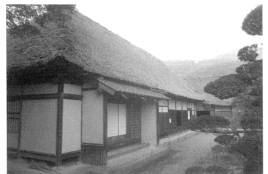
駐車場の整備が予定される旧尾形家住宅
