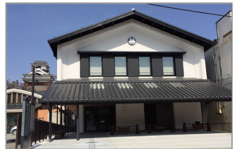
中部地区公民館の整備
