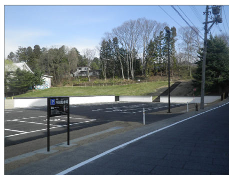
市道上山城通り線と市営月岡駐車場の整備
