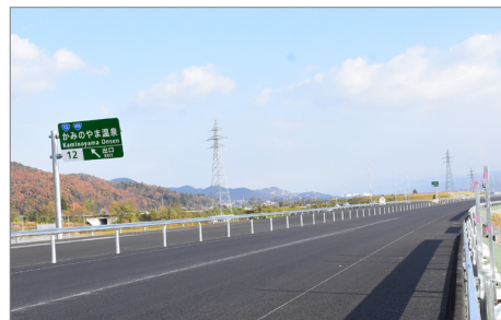
東北中央自動車道
