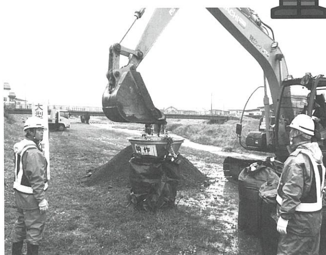
大型土のう作成訓練
